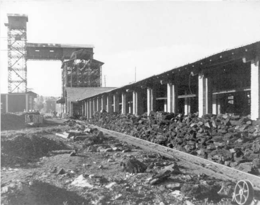
Miniera Le Carpinete, capannone di testata, palazzina Direzione, piazzale Sud incappannamento
