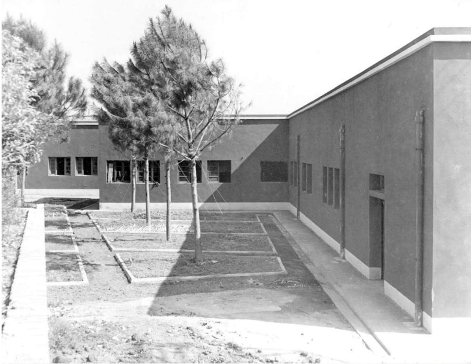
Miniera Le Carpinete, Cabina di trasformazione, officina elettrica
